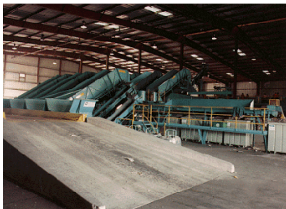
Εικόνα 70. Χώρος ζύγισης και χοάνες υποδοχής μιας μονάδας ανάκτησης υλικών.
